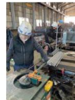
鉄筋材料の加工作業
