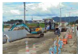
道路築造工事の土工作業風景
