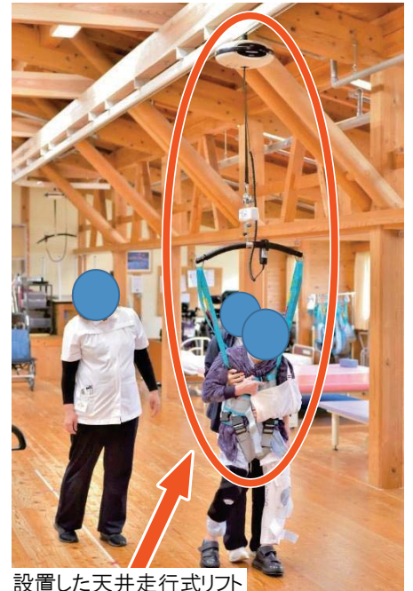
設置した天井走行式リフト
